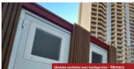
Modules sanitaires avec bardage bois - Monaco
