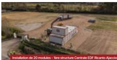
Installation de 20 modules - 1ère structure Centrale EDF Ricanto Ajaccio
